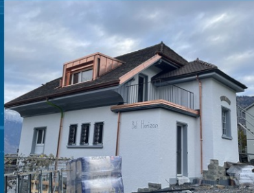
RÉNOVATION VILLA 1937 À MONTHÉY
